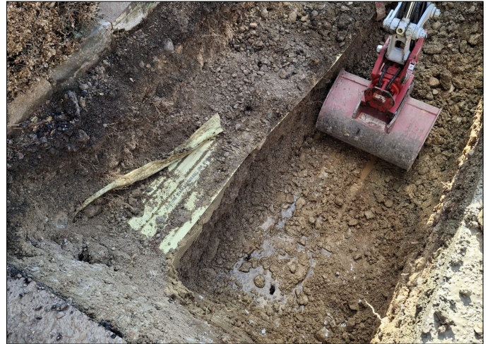
Laufend werden Rohrbrüche saniert.
