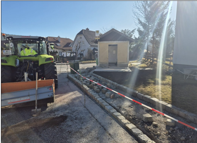
Die Bushaltestelle „Ortsstraße“ wird in Kürze fertiggestellt.
